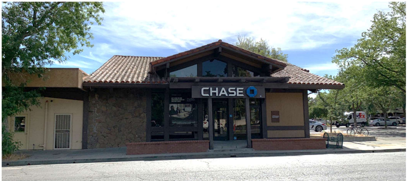
West façade, ESA 2022
